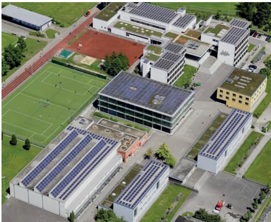
Die PV-Dachanlagen auf dem Schulhausareal Sunnegrund produzieren 67 Prozent des jährlichen Stromverbrauchs der Schulliegenschaften. Bild: Flyingcamera
