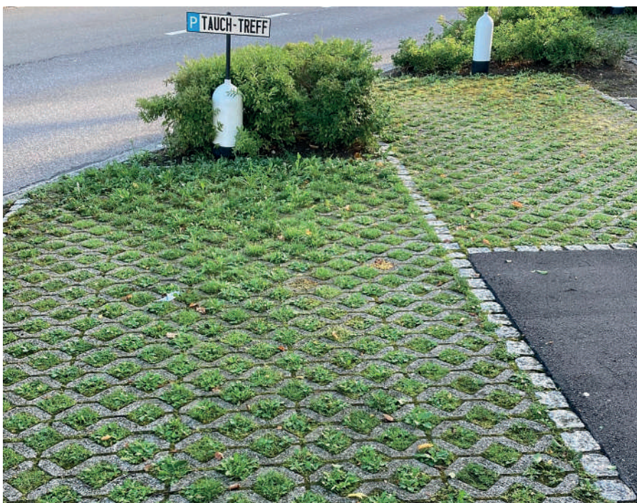
Entsiegelte und begrünte Parkplätze wie hier an der Bahnhofstrasse tragen zur passiven Kühlung an Hitzetagen bei und werden von der Gemeinde finanziell unterstützt. Bild: Renate Fleiner
